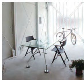
竣工時の室内。天井や左右の壁まですべて膜材をジッパーで繋ぎ合わせて設えた。白をベースに黄色や青を使ったポップな印象。キッチンにはシンプルな業務用キッチンを置き、自分たちが必要なものを簡単に追加できるようにした。
