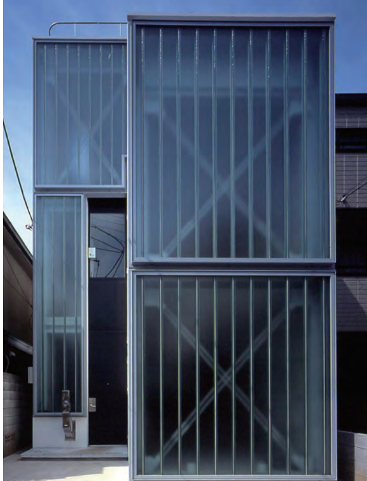
緑色を帯びた大きなガラスが特徴的な正面。写真では見えないが外壁はALC板を横向きにして積み上げている。時間が経っても古さを感じさせないシンプルでモダンな外観。
