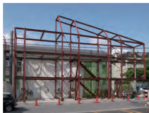
左：敷地に対しかなり骨太な骨格であることがわかる。振動対策として重量を出すように考えられた（撮影：わたなべけんたろう）
