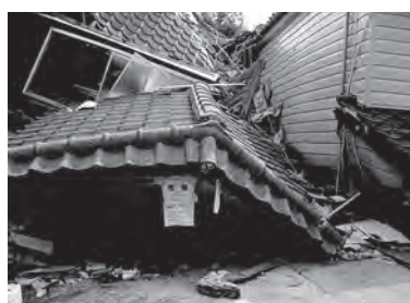
新潟県・中越地震の傷跡(H16年)
