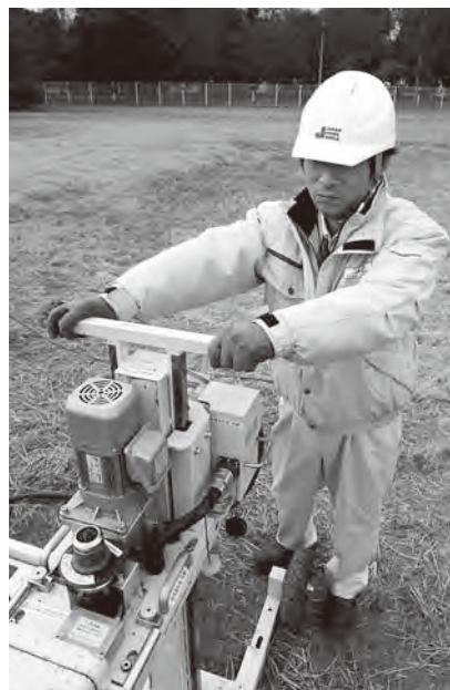
地盤調査で埋設物の有無も調べられる
