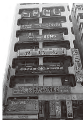
外装リニューアル前の林ビル
