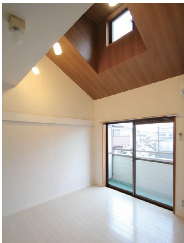
写真2 / 「立体天井」を用いた改修例
