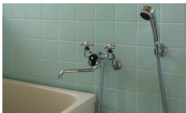
写真6 / 浴槽の金物だけを代えた改修例
