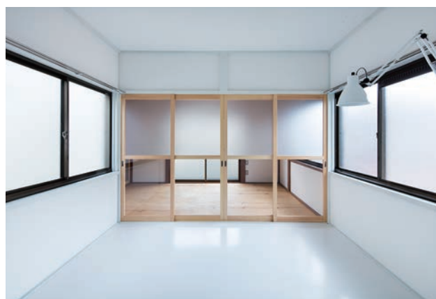
写真1／「広がり建具」を用いた改修例
