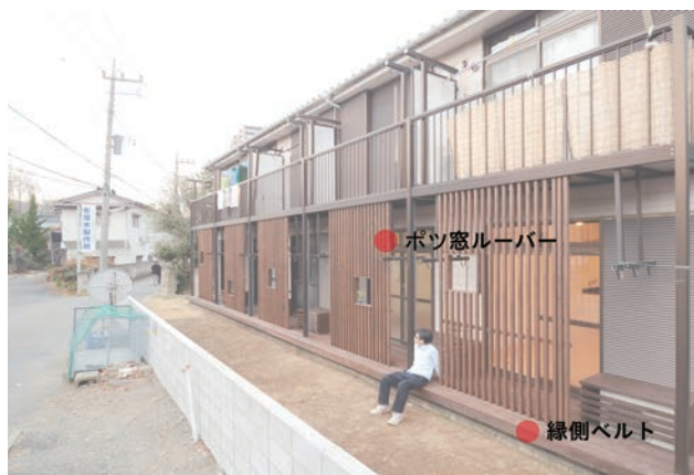
写真7 / アパートの外構の改修例
