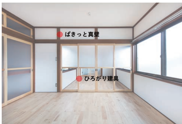
写真3 / 真壁の改修例
