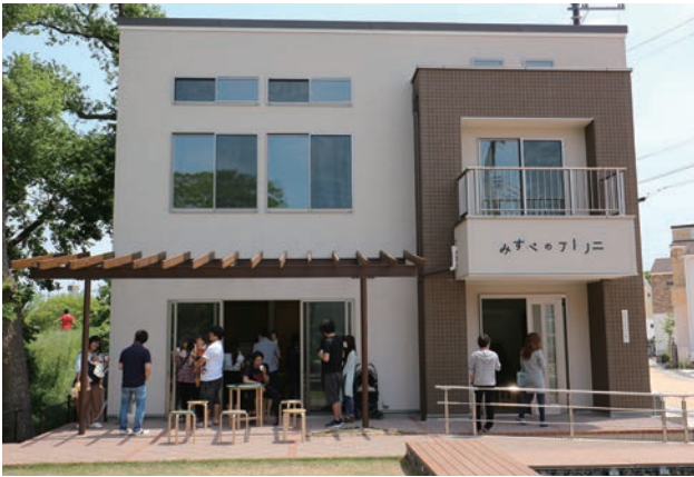
完成した「みずべのアトリエ」。公園と土手を一体としてコミュニティの拠点に
