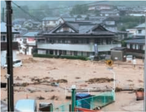
坂町西側の被害状況
