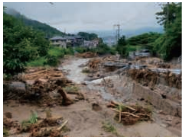
土砂で埋まった河川。現在は改修が進んでいる
