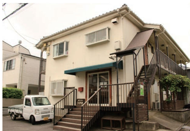
アパートの外観
