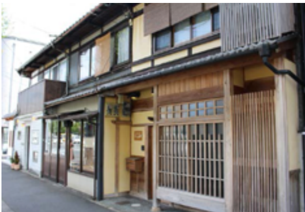
新大宮商店街の改修物件
