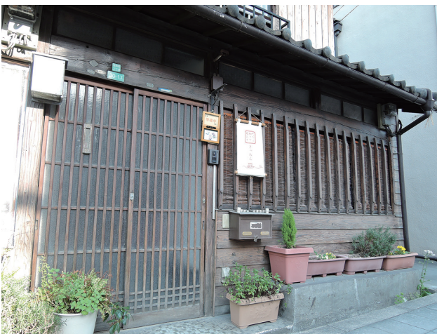
昭和町おうちカフェキッチン（家主と工事費を分担）
