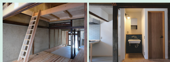
改修前の1階と水回り
