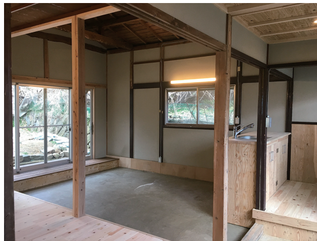
施工事例「ハグロBASE」築60年の木造平屋をアトリエハウスにリノベーション
