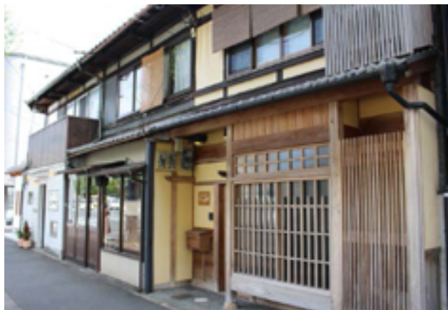
新大宮商店街の改修物件
