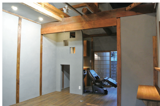
連棟平屋のリノベーション
