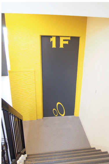
使えないエレベーターは、うまく壁材で隠している
