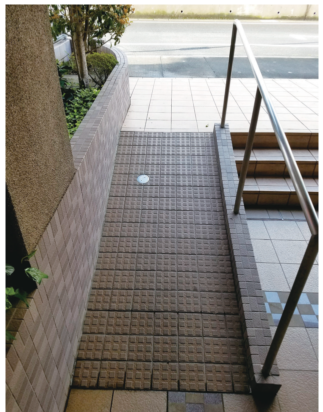
車椅子での出入りを可能にするバリアフリー工事の施工例
