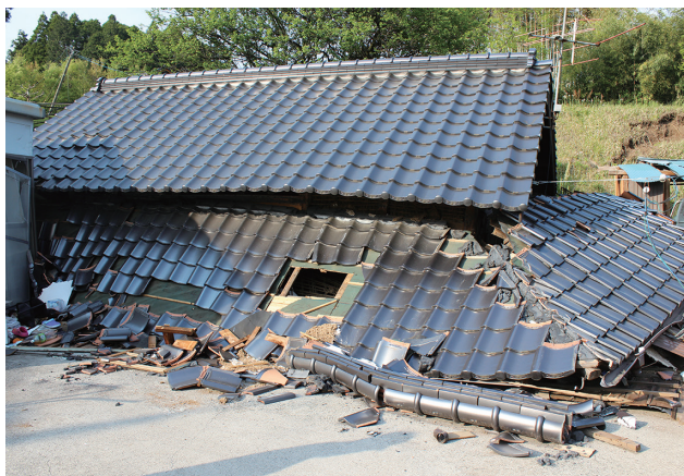
大切畑地区の倒壊家屋救出現場
