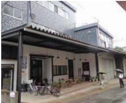
築古の事務所ビルの1階がおしゃれなカフェとして見事に再生された
