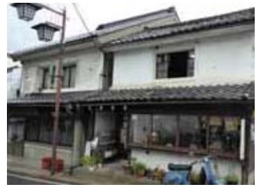
見学会の運営など、倉石氏と共にまちの活性化をけん引するナノグラフィカでは、古民家を改装してカフェ兼事務所としている
