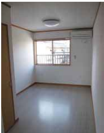
「トキワソウ」の室内。中連窓にして外部への飛び出しを防ぐなど、精神障がい者が住みやすいように仕立てている〈写真提供：阪井土地開発㈱〉
