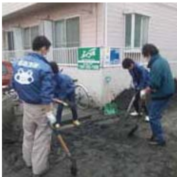
震災後しばらくは管理物件や道路からの泥のかき出し作業に追われた (写真提供：(株)明和地所)
