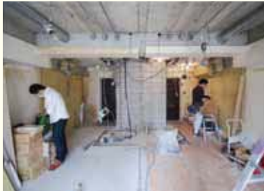
2戸の戸境壁を取り壊し、1戸にした部屋も 〈写真提供：(株)メゾン青樹〉
