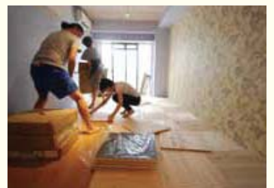
床材も自由に。床材を張る作業は、既存入居者を巻き込んで行なう（写真提供：㈱メゾン青樹）
